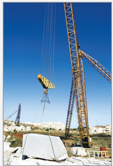
Resim 2.2: Vincin mermeri kaldırması
